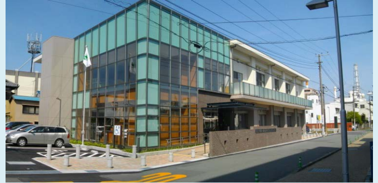
完成外観写真
